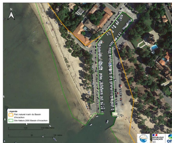
Figure 8 – Vue aérienne des travaux de réaménagement du Port du Bety à Andernos-les-Bains.
